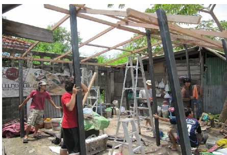
. Het nieuwe huis wordt gebouwd
